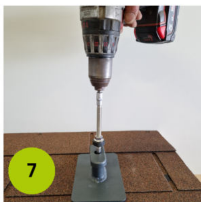
*Verschrauben mit der Stockschraube
