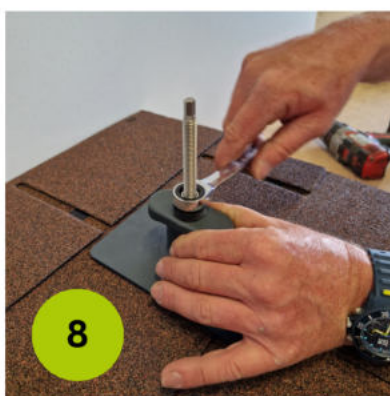
*Verschrauben mit der Stockschraube
