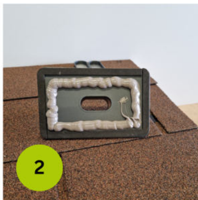
*Aufsetzen des Halters ca. 1 cm unter dem oberen Bitumenschindel
